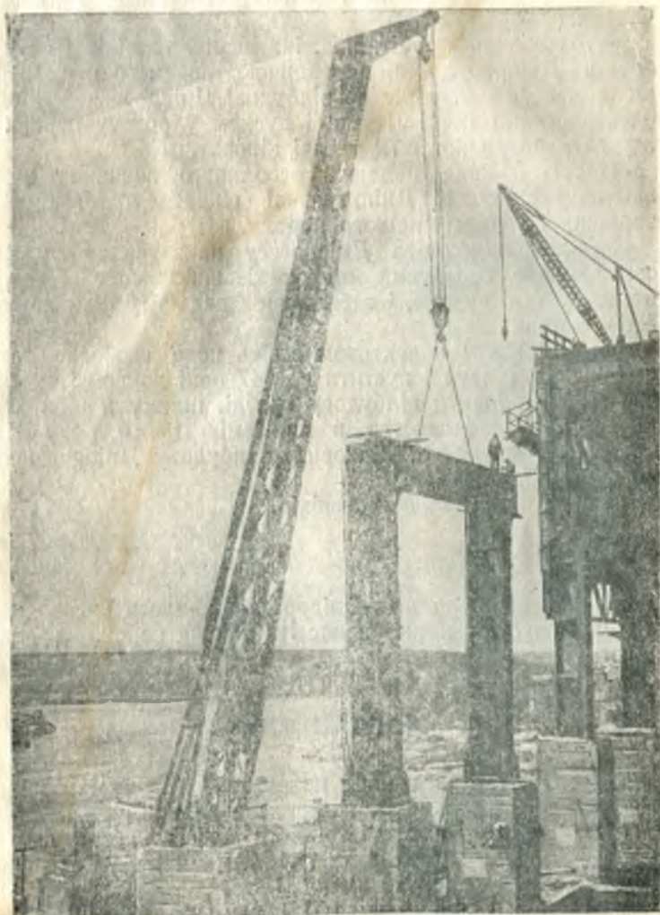
Складання каркаса будинку гідроелектричної станції із службового моста
