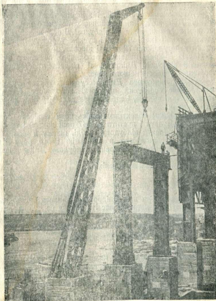
Складання каркаса будинку гідроелектростанції із службового моста
