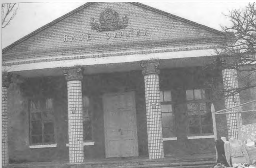
Приміщення Будинку культури
