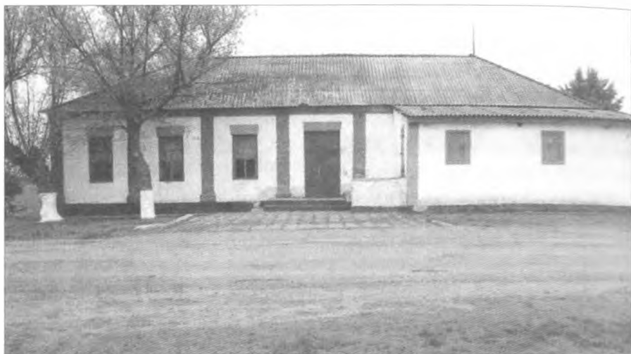
Приміщення Будинку культури
