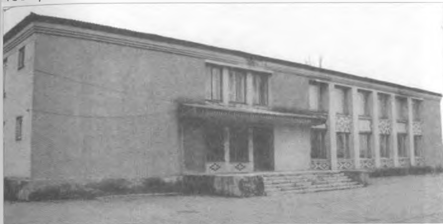
Приміщення Будинку культури
