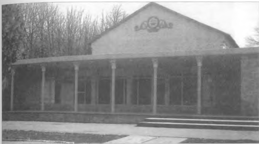
Приміщення Будинку культури
