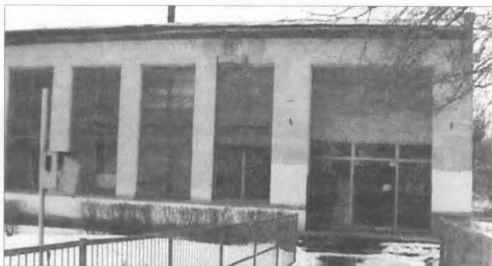
Приміщення Будинку культури
