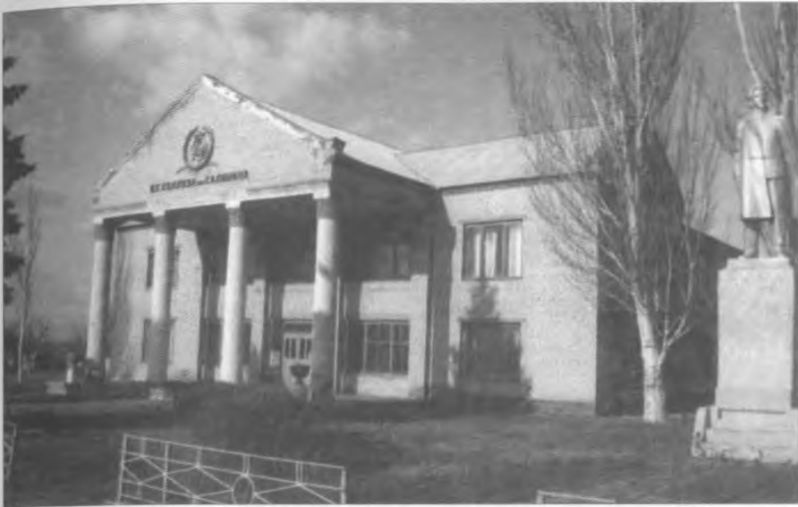
Приміщення Будинку культури
