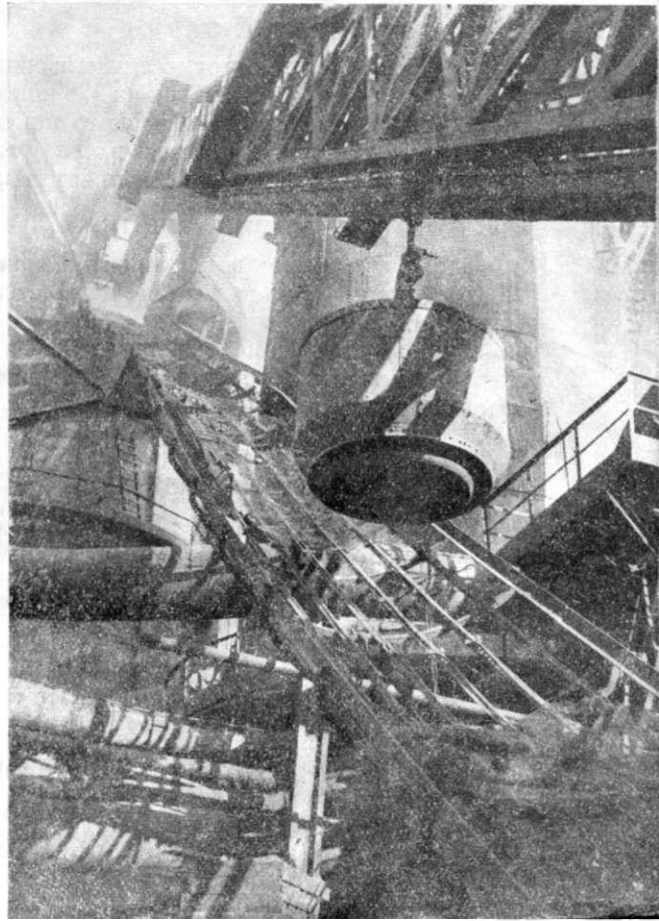
На стройке станции.
