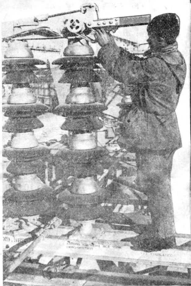
Монтаж изоляторов на линии передачи
