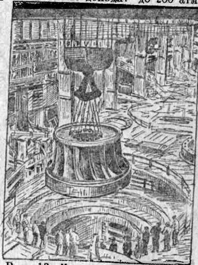
Рис. 13. Установка на место рабочего колеса турбины.
