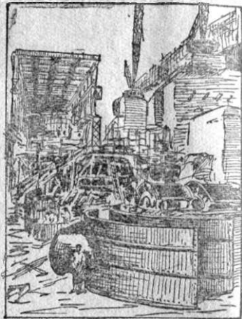
Рис. 8. Монтажные работы ГЭС.
