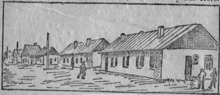
Рис. 15. Здание управления Алюминиевым Комбинатом.
