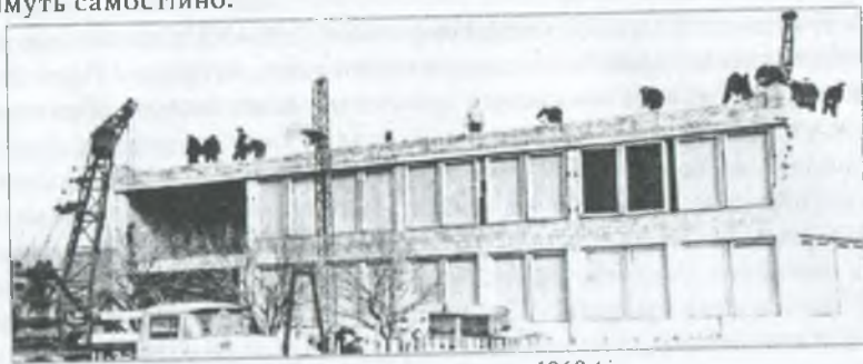
Будівництво ресторану, 1969 рік
