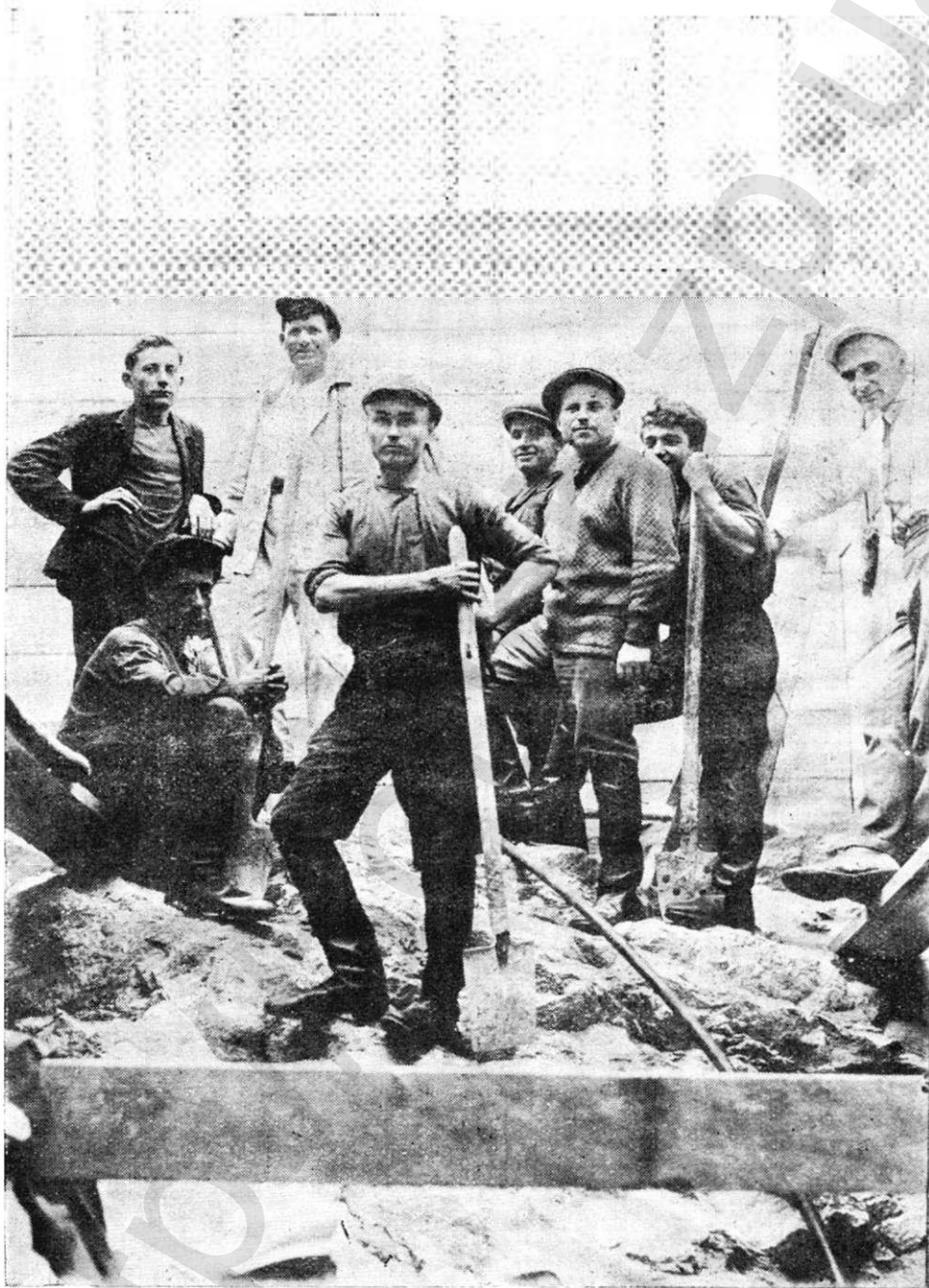
Борьба за встречный. Ударная бригада электриков за работой по бетонированию подшефного ей 12-го бычка плотины.
