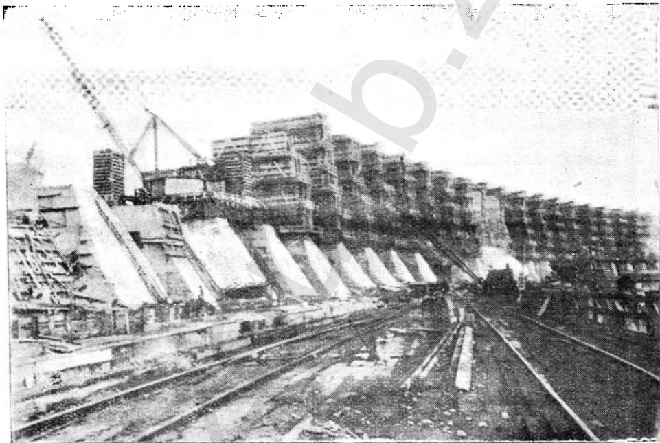
Общий вид плотины со стороны нижнего бьефа после выполнения встречного плана, в декабре с. г.
