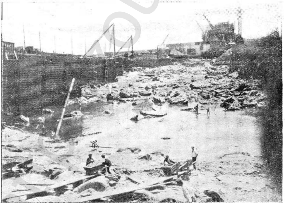
Откачанный котлован среднего протока весной 1930 г.
