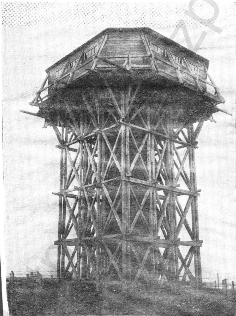
На Заводстрое. Временная водонапорная башня на площадке „А“
