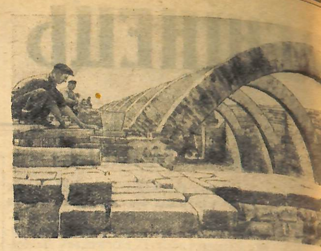
Одеська область. В колгоспі ім. Ватутіна, Котовського району освоєно безлісне будівництво господарських будівель. Для цієї мети використовуються місцеві будівельні матеріали власного виробництва.
