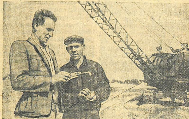
Запорізька область. Механізатори будівельно-монтажного управління № 5 «Укрводбуду» взяли нові підвищені зобов'язання на честь XIX з'їзду партії. Екскаваторник Яків Сирота, ставши на стахановську вахту на честь наступного з'їзду партії, зобов'язався виконувати по дві норми за зміну.
